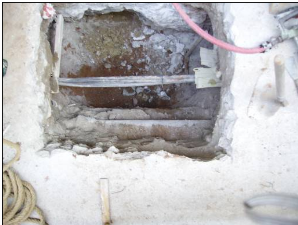
Foto 4: Pou de mina i serveis d'electricitat.
