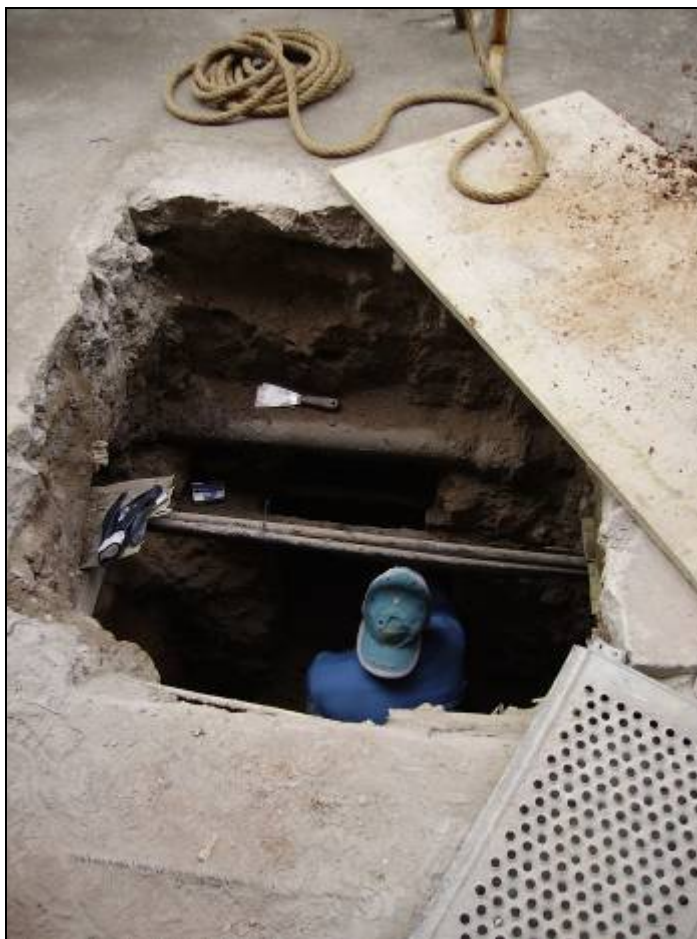
Foto 5: Vista del pou en l'inici de l'excavació de la mina.
