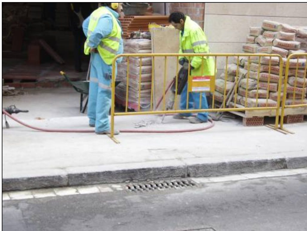
Foto 3: Vista de l'excavació del pou de mina a la vorera del carrer Hospital .
